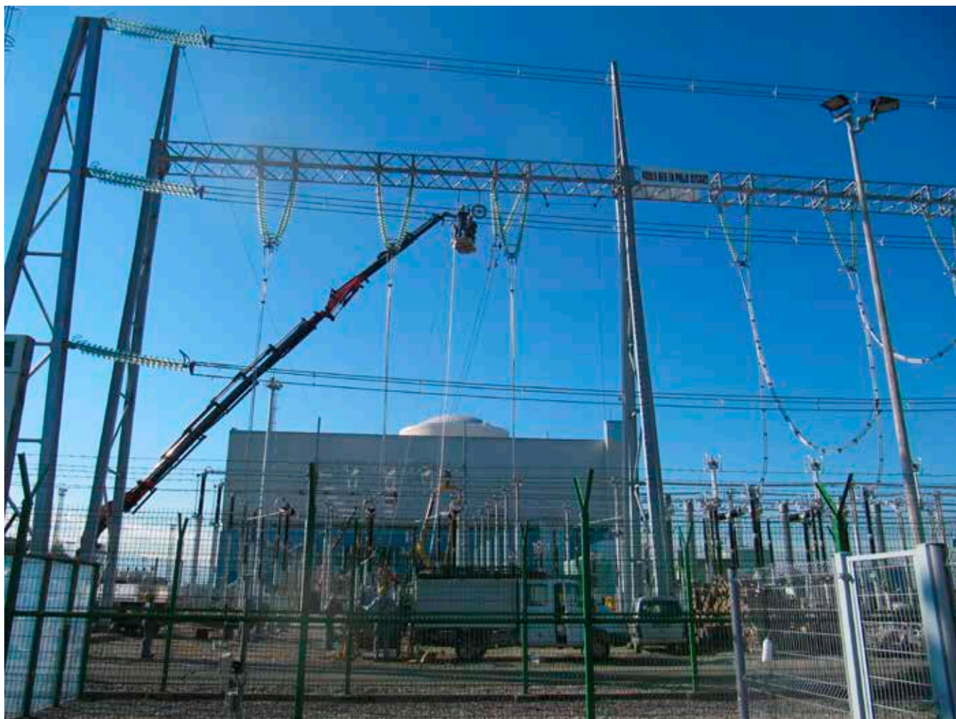
400 kV stikališče NEK: dobava sekundarne opreme, vsa preizkušanja (FAT, SAT) in sodelovanje pri spuščanju v pogon
