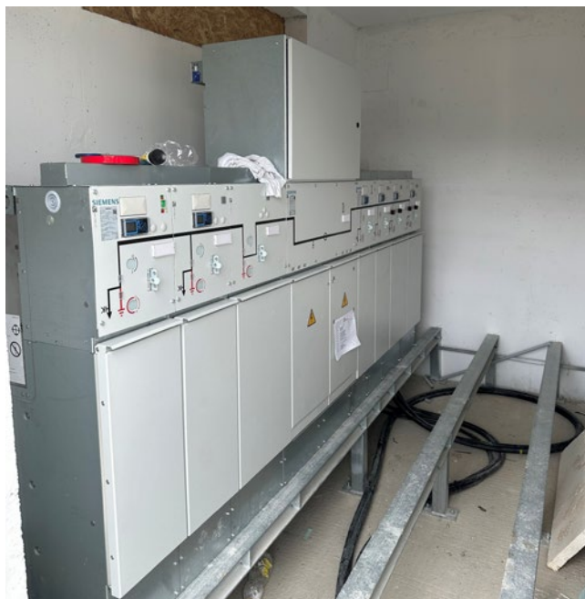
Slika 2: Montaža SN celic
