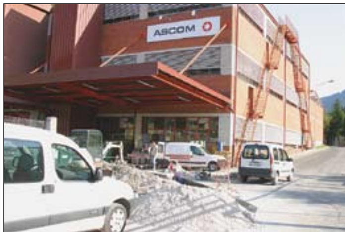
Dela pred Ascomom, obnova in povečanje zmogljivosti posameznih vodov
